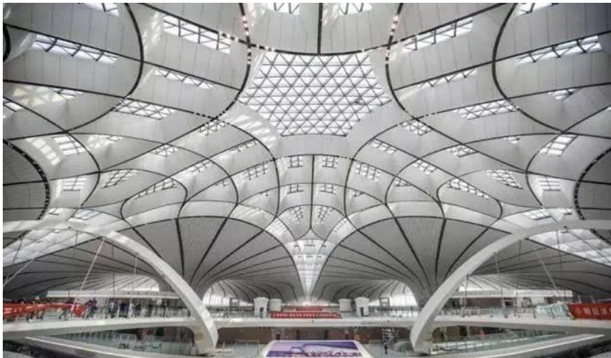
瑞客矿物漆被用于北京大兴新机场核心区域
