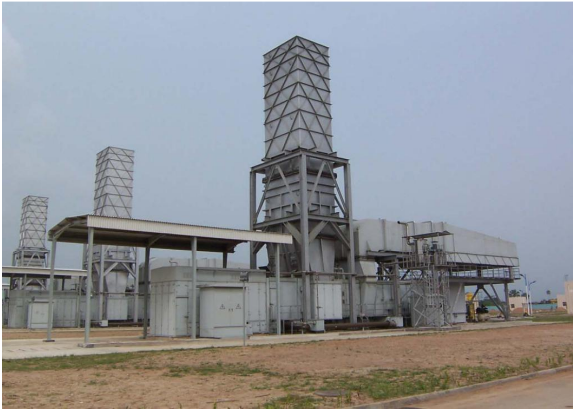
帕帕兰多燃机电站一期工程
