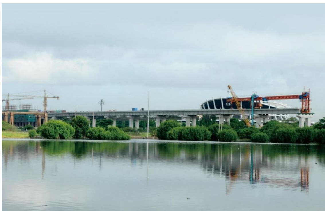
拉各斯轻轨施工场景
